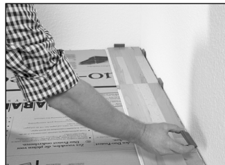
Plochu pokládky si vycentrujte/upravte a první řadu palubek upravte zaříznutím.
