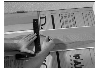
Poslední palubka první řady se s přihlédnutím k nezbytné vzdálenosti od stěny zkrátí na nezbytnou délku. Uříznutý kus palubky se použije jako začátek druhé řady.
