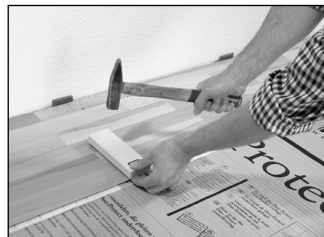
Čelní drážky sklepněte kladivem a ochranou proti úderům. Podélné a čelní drážky se přitom automaticky spojí. Tímto způsobem pokládky pokračujte v celé místnosti.
