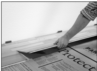
Další řadu začněte opět zleva. Palubky secvakněte na podélné straně. Lepení palubek není třeba.
