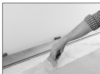
Alternativně je možné, pokládat třívrstvé dřevěné podlahy Parador i celoplošným lepením.
